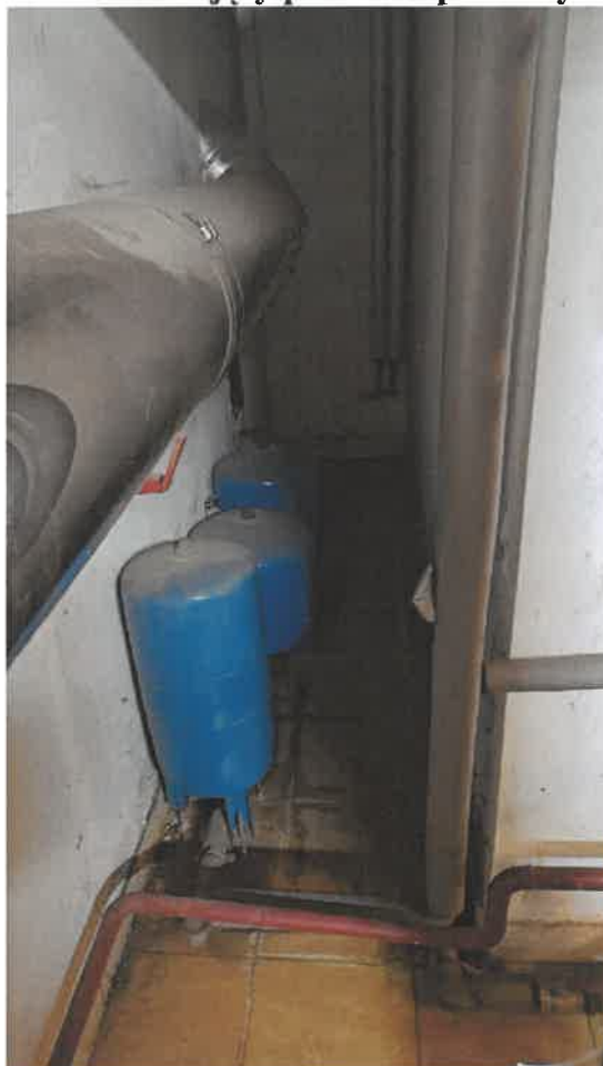
Fot. Nr 3 widok na istniejący przewód spalinowy do likwidacji
